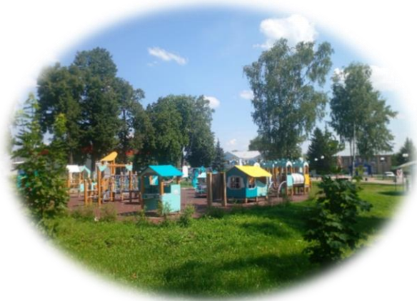
Строительство детской площадки в с. Кочкурово
