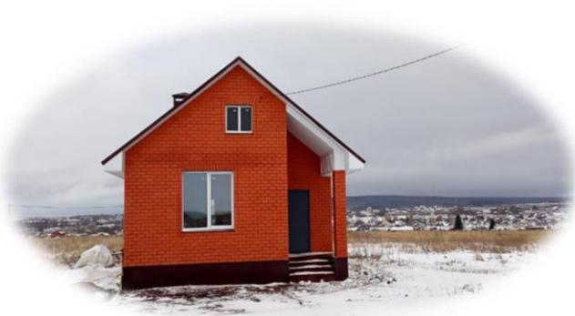
Строительство жилого дома по договору социального найма в с. Кочкурово
