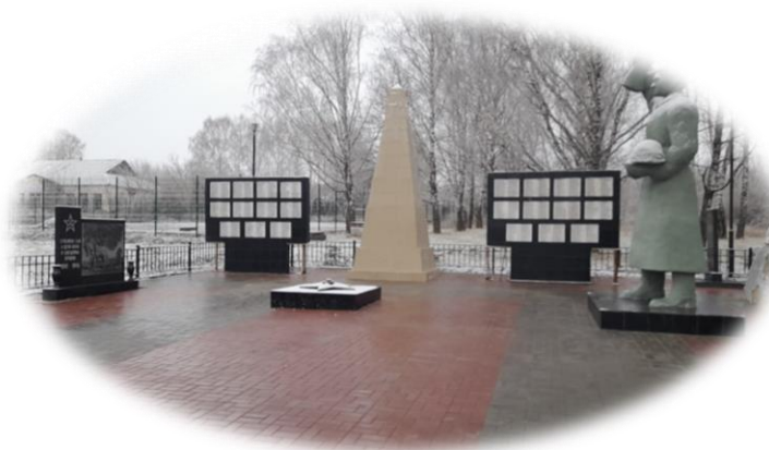
Капитальный ремонт памятника воинам, погибшим в Великой Отечественной войне в с. Сабаетово
